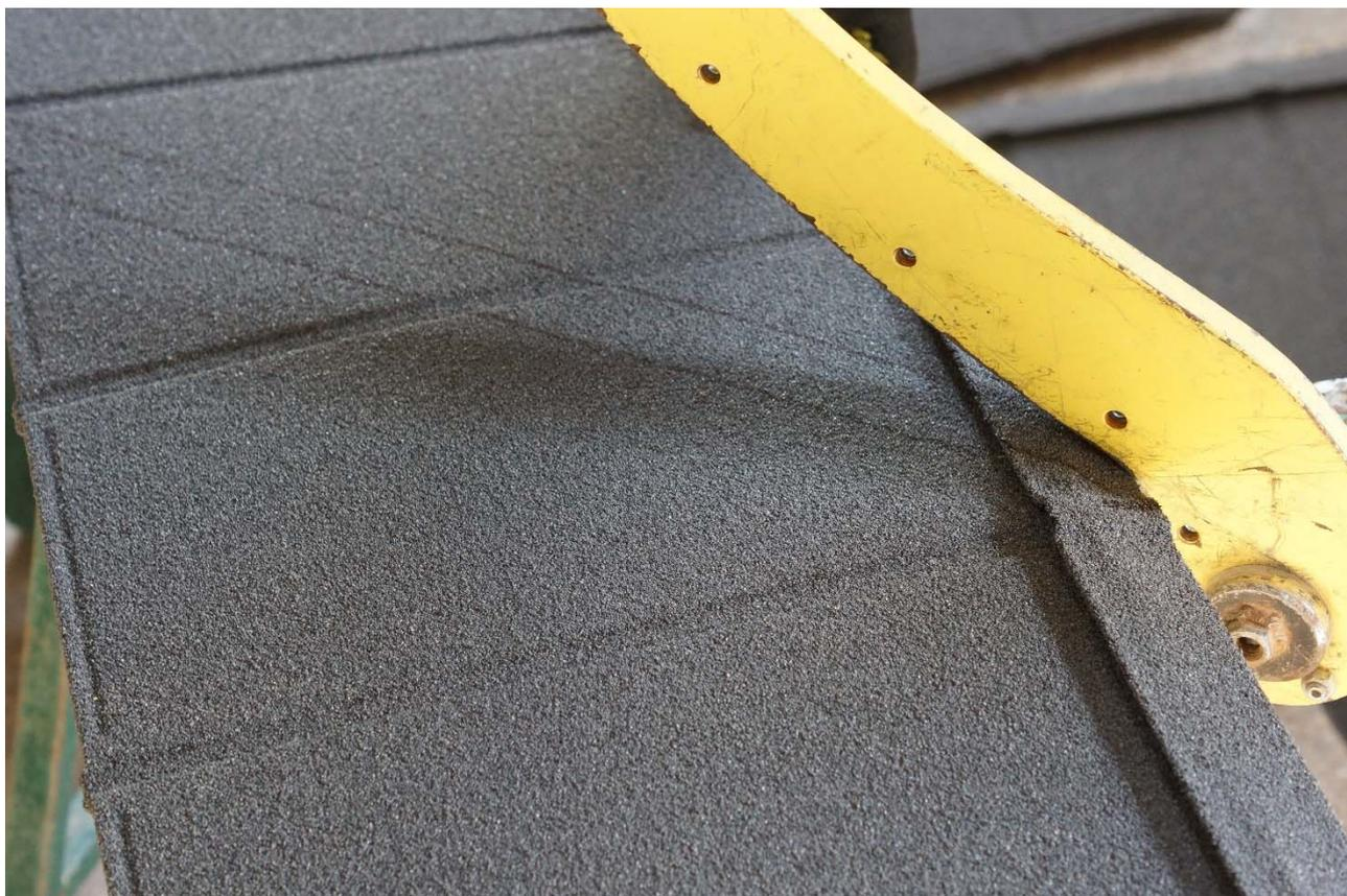
Укладка рядовой черепицы требует подреза полки для укладки в боковые замки
