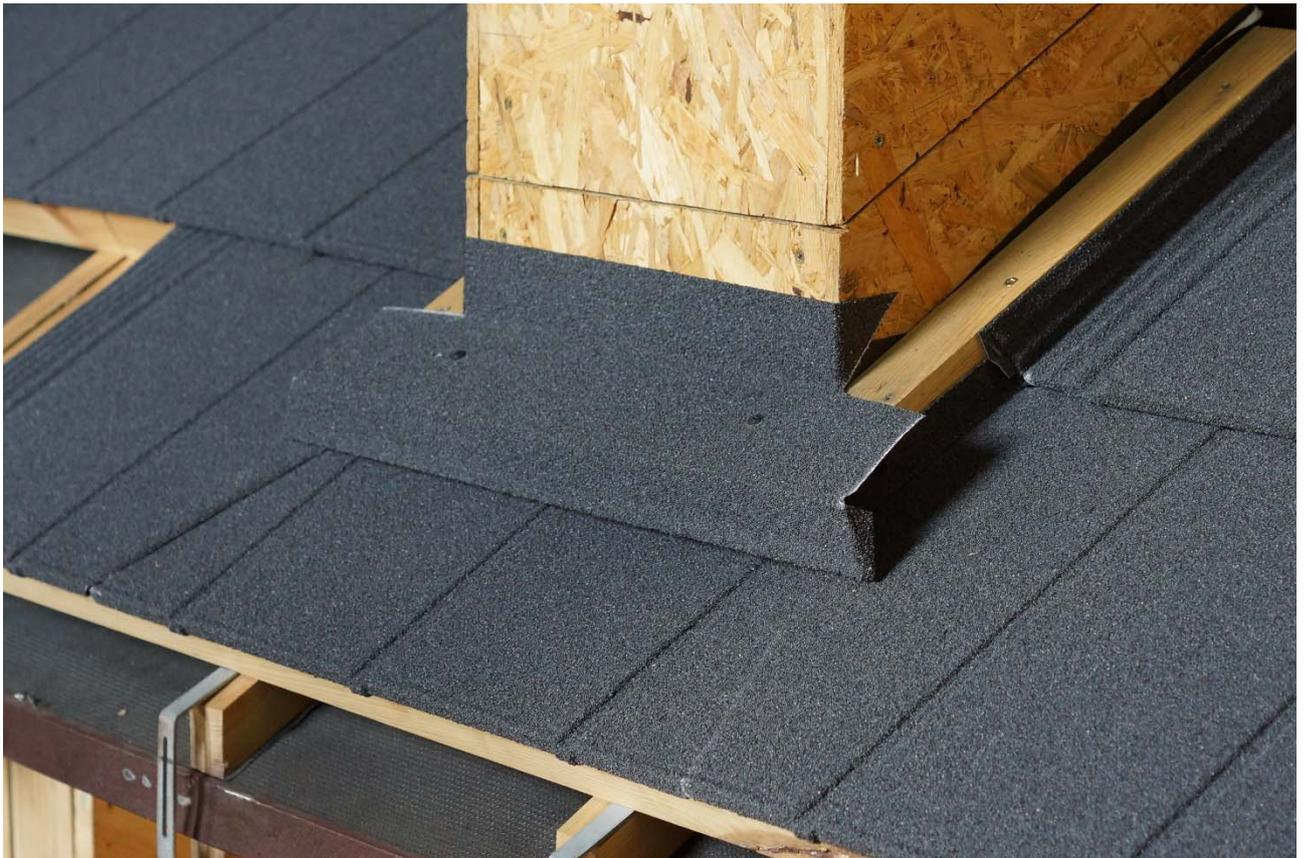
Установите универсальную планку примыкания сбоку трубы
